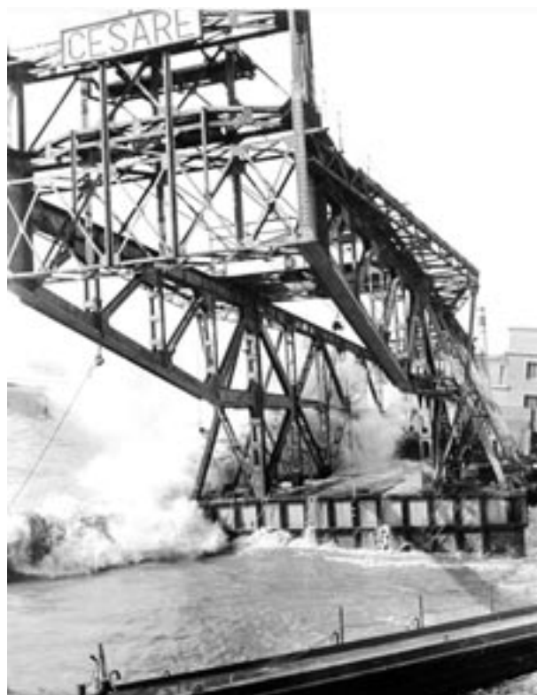
Foto 11 - Calata Derna. Il pontone posa-massi Cesare rompe gli ormeggi
