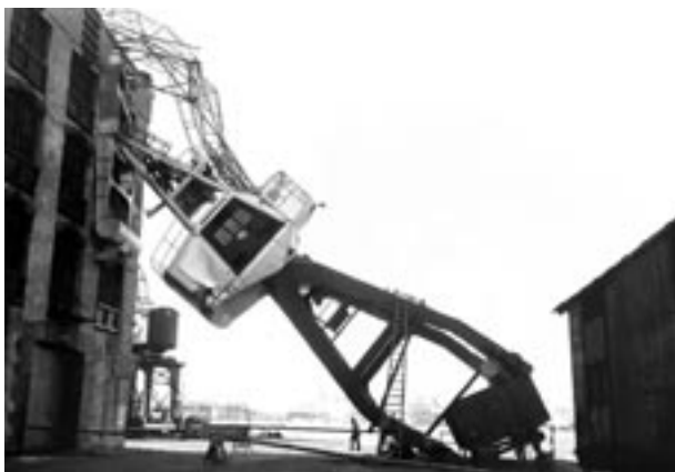
Foto 17 - Gru abbattuta a ponte Eritrea
