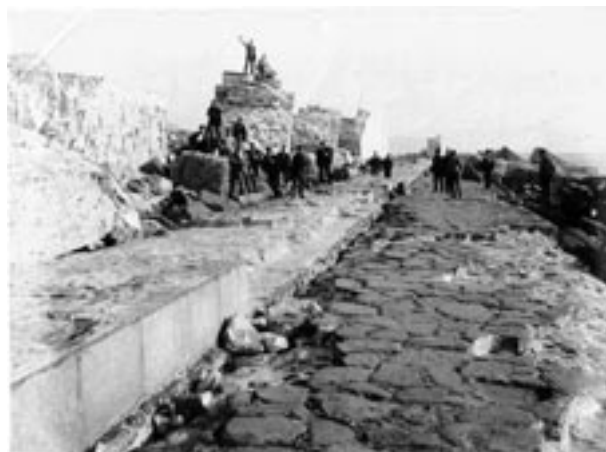
Foto 16 - Guasti causati al molo Duca di Galliera dalla mareggiata del 27-28 novembre 1898
