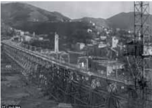
1946. Il viadotto provvisorio completato
