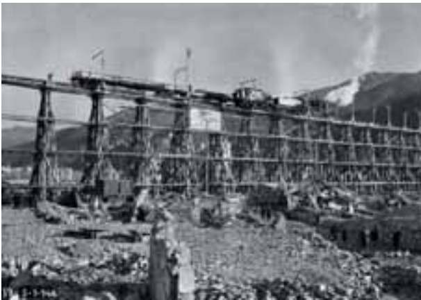
1946. Il viadotto provvisorio in legno, con linea aerea trifase, è quasi completato
