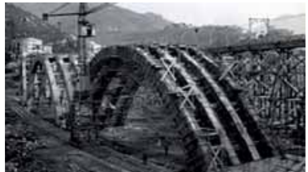
1948. Un particolare della costruzione degli archi
