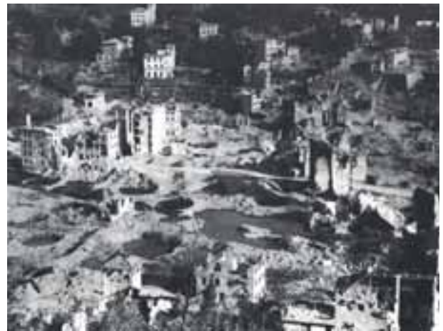
La cittadina e il viadotto sono ormai ridotti ad un cumulo di macerie
