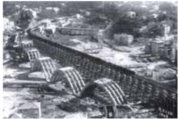
1948. Una fase avanzata della costruzione degli archi del nuovo viadotto in cemento armato. Nel frattempo quello provvisorio svolge egregiamente la sua funzione
