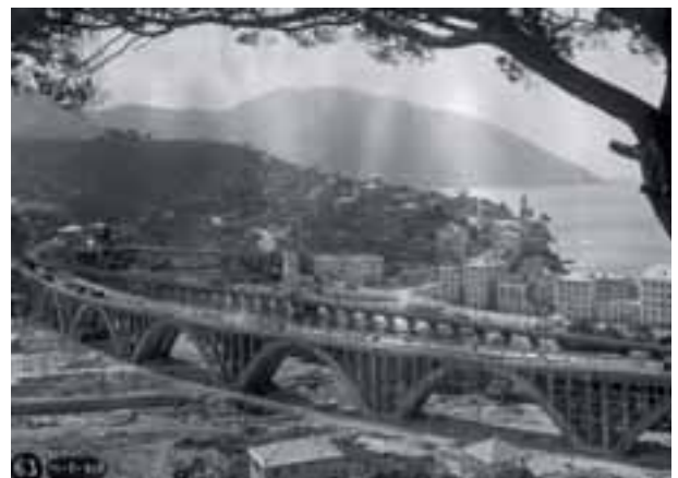
1948. I due viadotti
