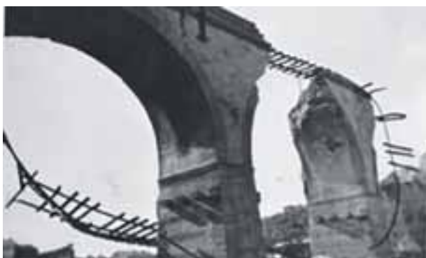
Resti del viadotto distrutto
