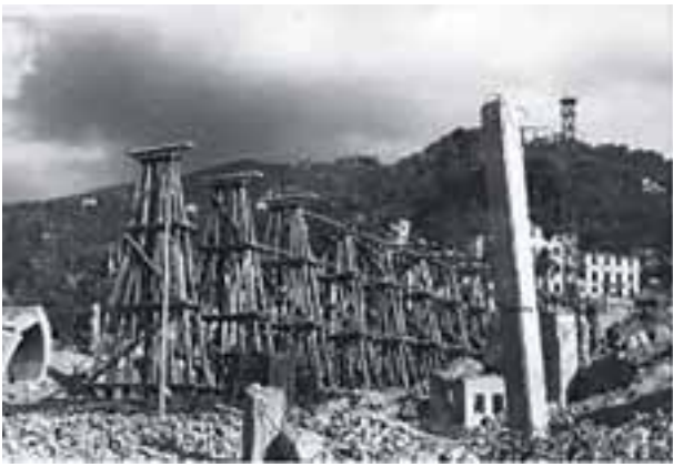
1945. Una fase della costruzione del viadotto provvisorio in legno
