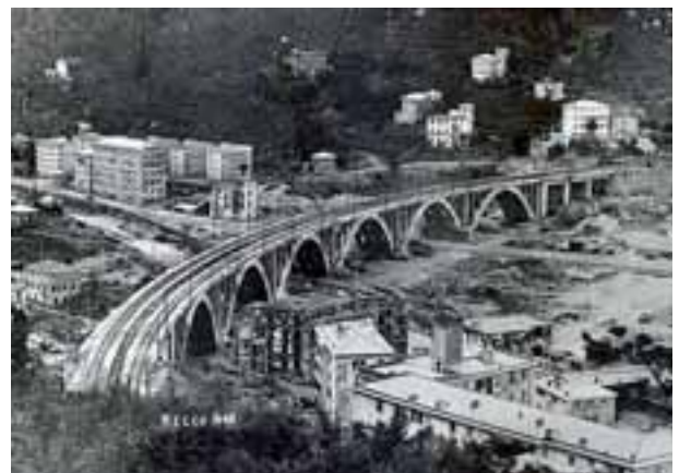
1949. Il viadotto provvisorio in legno è stato ormai smantellato
