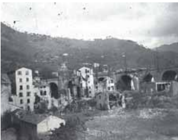
La città è in rovina, ma il viadotto è ancora in piedi
