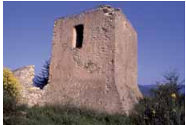
La Torre di Bastia già in parte sbrecciata, 26-6-2008
