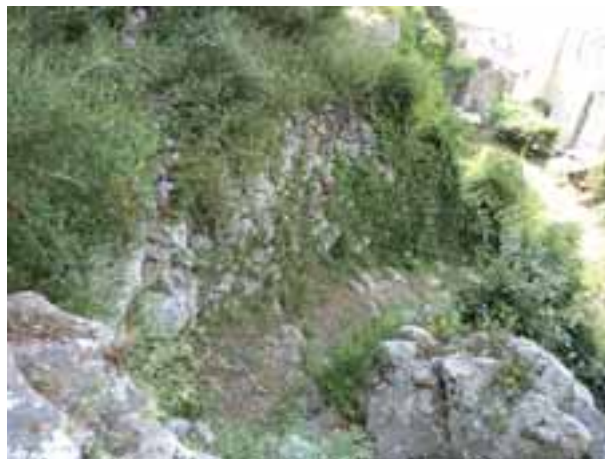
L'alto pregevole muro a secco ( muàia ) che sostiene il pendio a monte del sentiero che dall'Arma Crosa scende alla borgata
