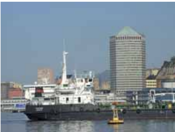
(foto 15) - La Torre Nord San Benigno, o "Matitone", ultimata nel 1992.
