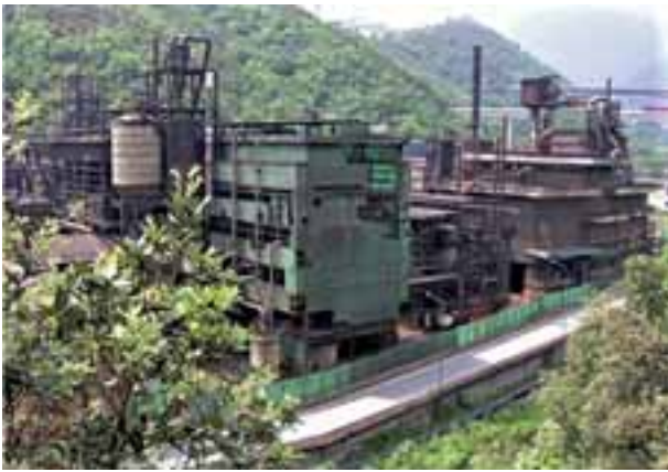
Lo Stabilimento Stoppani già dismesso, prima dell'inizio dello smantellamento attualmente in corso
