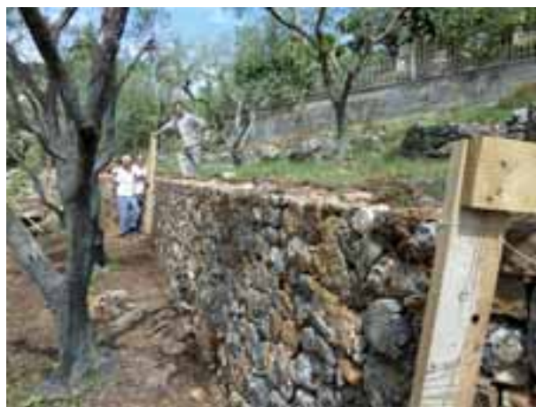
La costruzione di muri a secco
