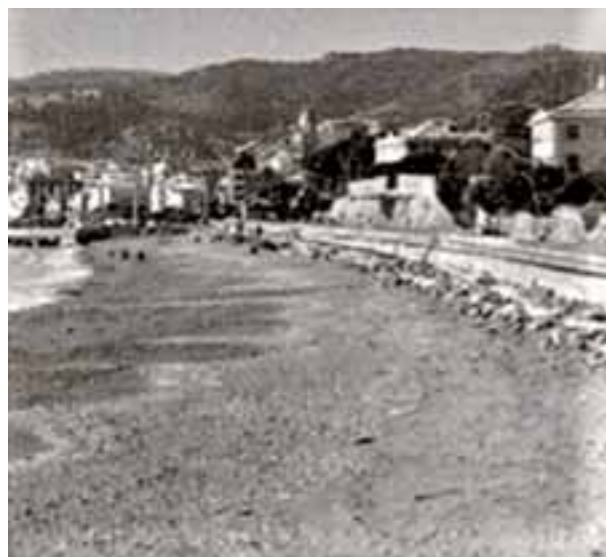
Il muraglione anti-sbarco in calcestruzzo costruito dall'Organizzazione Todt
