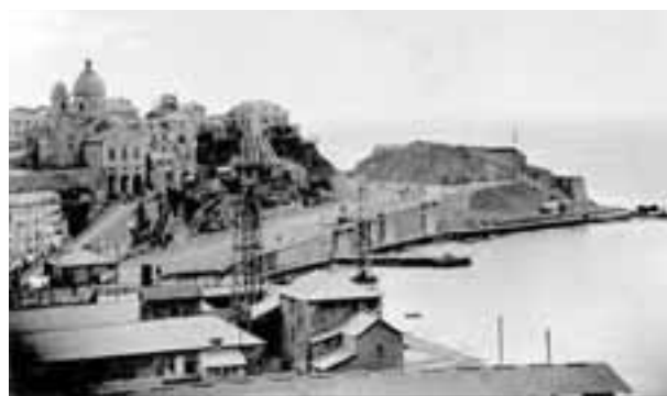
Corso Italia, lavori in corso
